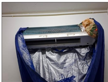
รูปที่ 3-38 เจ้าหน้าที่ทำความสะอาดระบบปรับอากาศ
