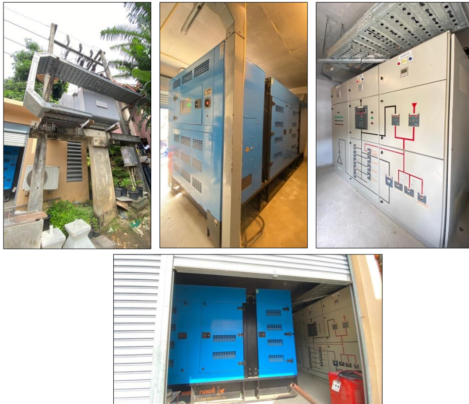
รูปที่ 3-17 หม้อแปลงไฟฟ้า ห้องระบบไฟฟ้า และระบบไฟฟ้าสำรอง
